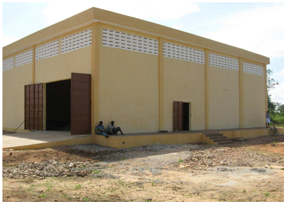
Vue partielle de l'entrepôt
