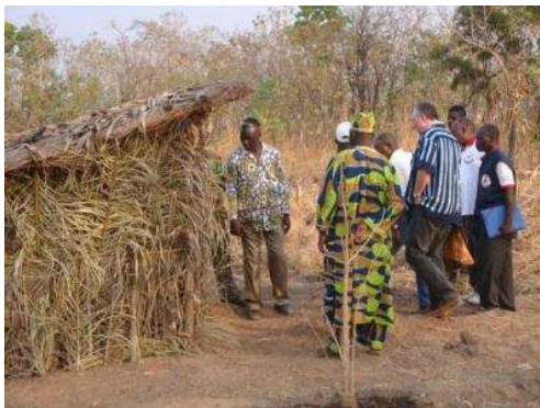
Super structure d'une latrine SANPLAT
